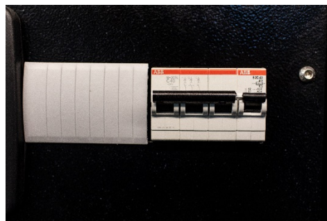
Электрическая часть ДГУ производства АВВ
