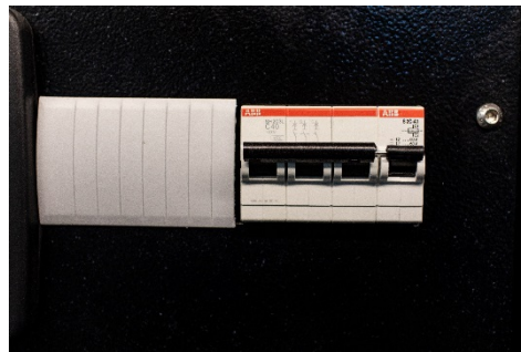
Электрическая часть ДГУ производства АВВ
